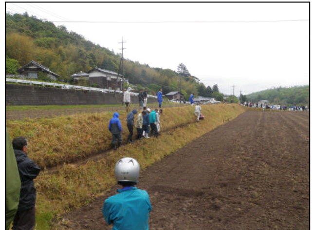
小段造成の様子
