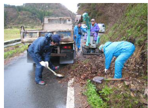
農地維持・水路の泥上げ作業
