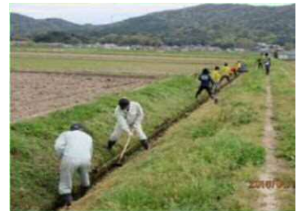
水路の泥上げ作業
