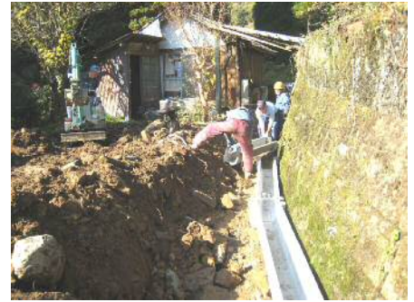
長寿命化・コンクリート水路へ更新
