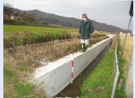
水路の擁壁補修
