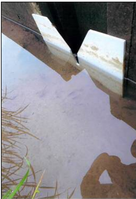
降雨後のせき板の設置状況
