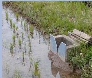
協議会提供堰板
