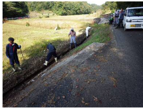
水路の泥上げ
