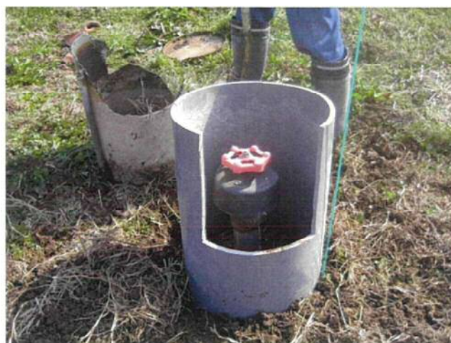
給水栓の補修(自主施工)
