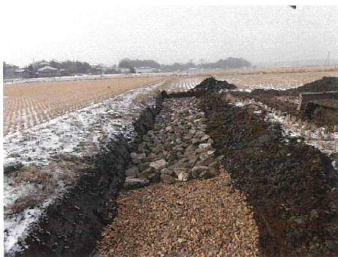
暗渠排水の補修(御船畷)
