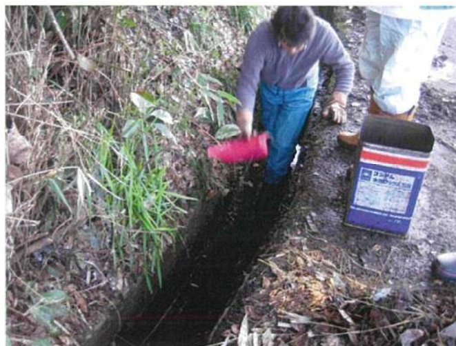
日焼用水の漏水防止
