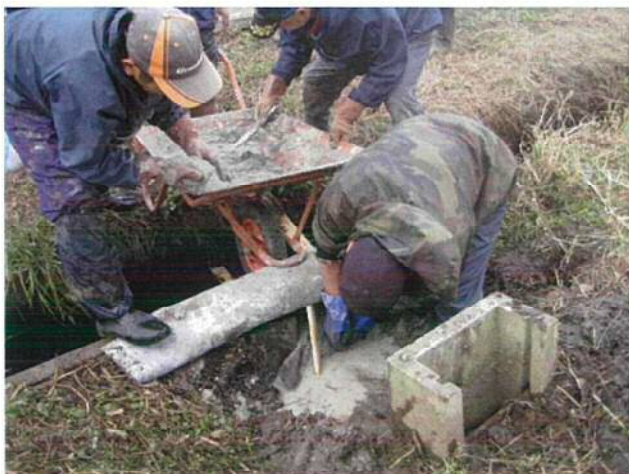
落水口の補修
