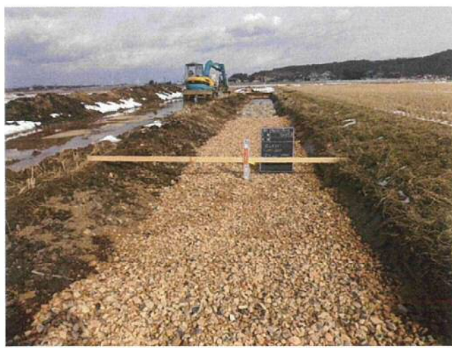
暗渠排水の補修(御船畷)
