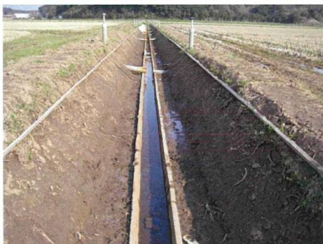
中間検査(法面整形後)
