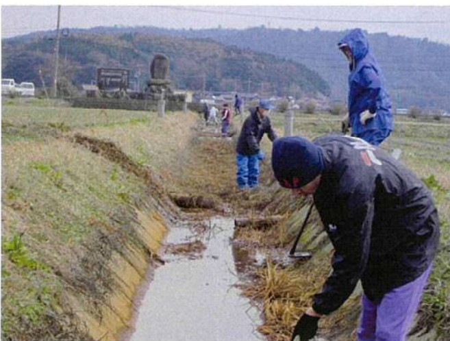
支線排水路の泥上げ(人力)
