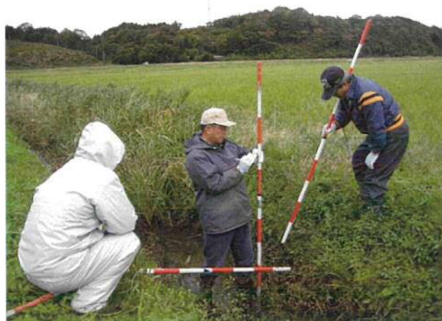
水路法面補修工事発注準備(測量・設計)
