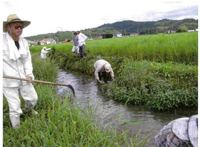
幹線排水路の草刈り・泥上げ
