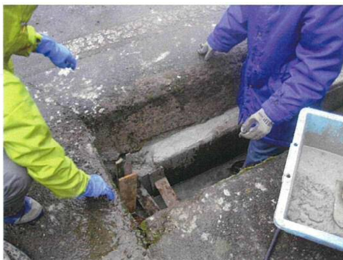
日焼用水の漏水防止
