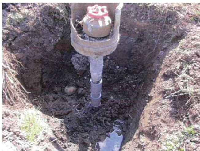
給水栓の補修(委託)
