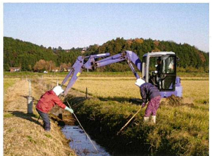
支線排水路の泥上げ(重機)
