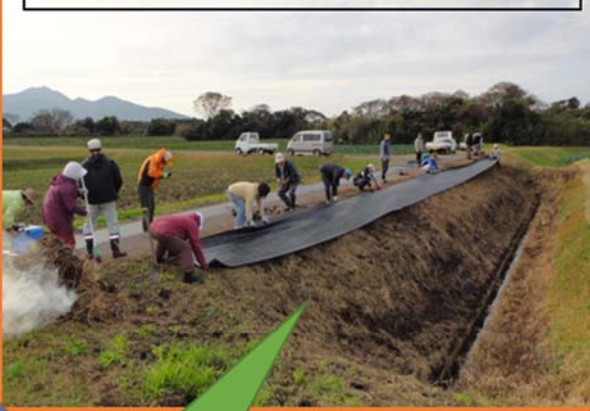
平成28年11月事前の防草シート張り
