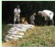
漏水箇所の補修
