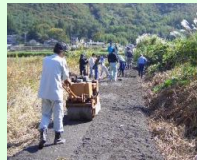
未舗装農道の舗装
