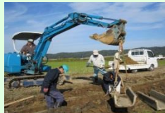
コンクリート水路の更新
